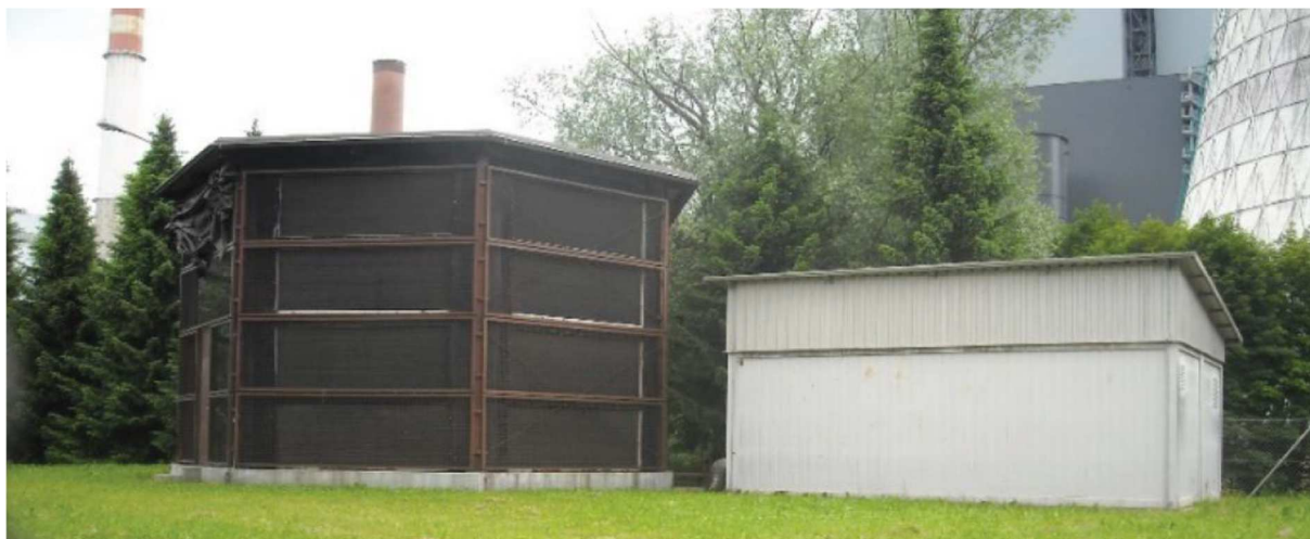
Fig. 56 Intake Shaft Šoštanj II
