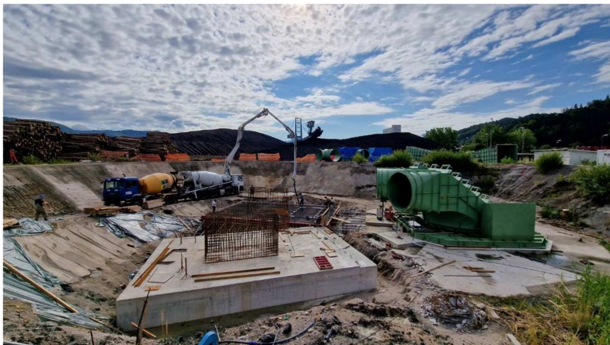
Fig. 57 Ventilation Shaft Nove Preloge II – NOP II
