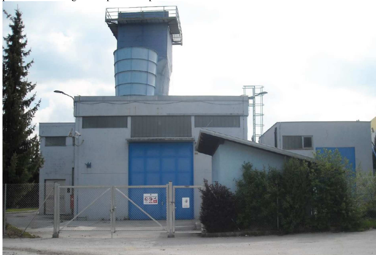
Fig. 53 Ventilation Shaft Pesje
