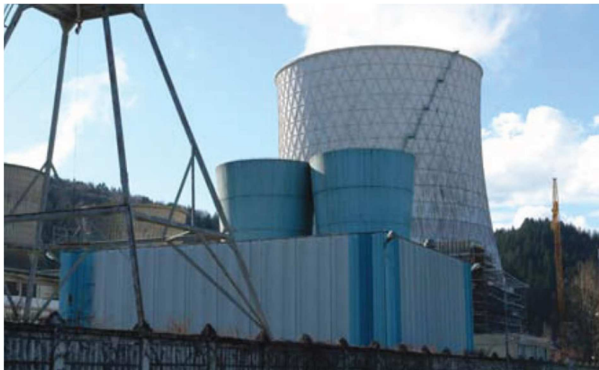
Fig. 54 Ventilation Shaft Šoštanj I
