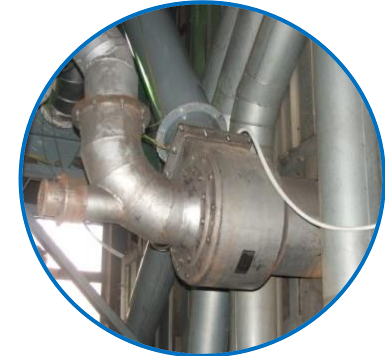
Palnik na obiekcie rzeczywistym
